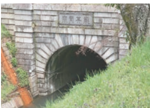
琵琶湖疎水第1トンネル西口洞門
