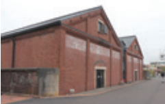
旧紐育スタンダード石油会社倉庫
