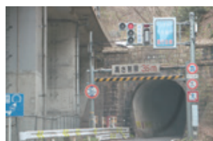
柳ヶ瀬トンネル 福井県側
