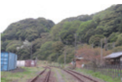
旧敦賀港駅線路
