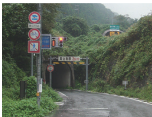
柳ヶ瀬トンネル 滋賀県側
