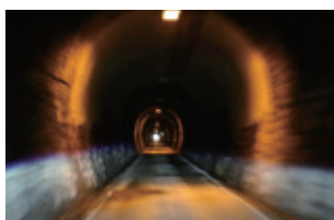
柳ヶ瀬トンネルの内部
