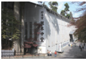
根本中堂（改修中）
