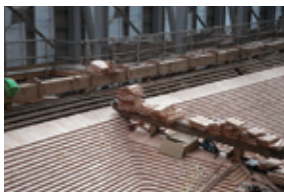
廻廊屋根の羽葺き
