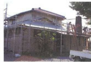
工事中の寺村家
