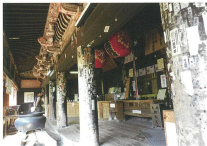
観音堂（修復前）
