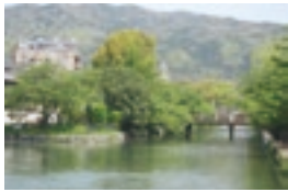
鴨東運河・夷川発電所前
