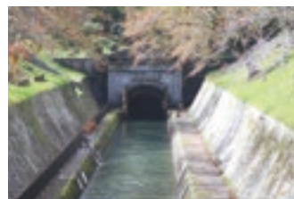
第一トンネル洞門
