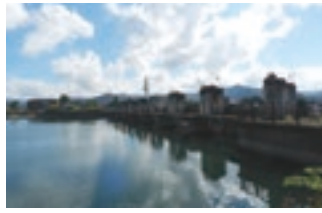
瀬田川洗堰上流部
