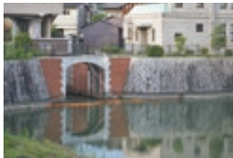
第二疎水取水口
