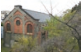
旧蹴上発電所
