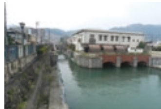
第一疎水取水口
