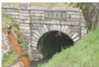
第一トンネル西口洞門
