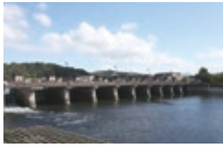
瀬田川洗堰下流部
