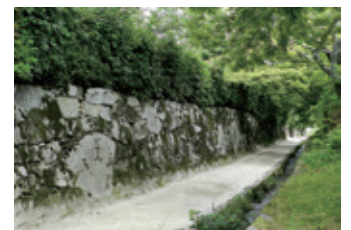
穴太衆積み石垣
