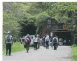
山中トンネル
